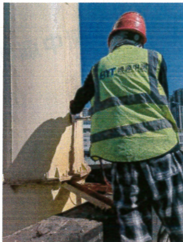
1 号天然气锅炉排气筒
